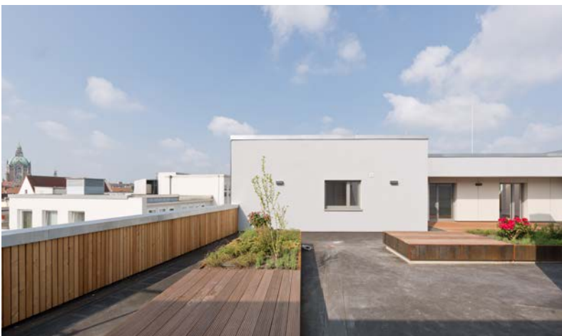
Zwölf Wohnungen sind auf dem Dach des City-Parkhauses Windmühlenstraße mit Blick auf die Oper entstanden. Insgesamt 7,7 Mio. Euro investiert die union-boden GmbH in den Bau der zwölf Apartments und die Modernisierung des gesamten Hauses.
