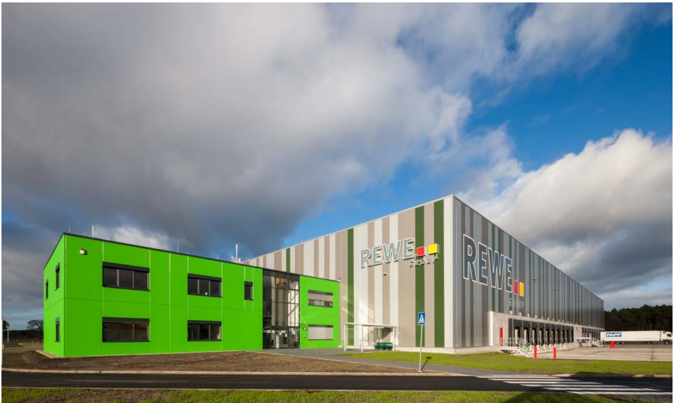
Nach neun Monaten Bauzeit ist im November 2015 das REWE Group Frische-Logistikzentrum in Berkhof in Betrieb genommen worden. Aus dem Wedemärker Ortsteil werden rund 1.300 REWE- und Penny-Märkte in sechs Bundesländern zentral mit Obst und Gemüse beliefert.
