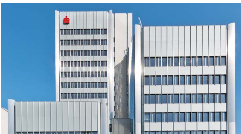
Die Sparkasse Hannover hat ihre Hauptverwaltung am Raschplatz aus den 1970er Jahren aufwändig saniert.
