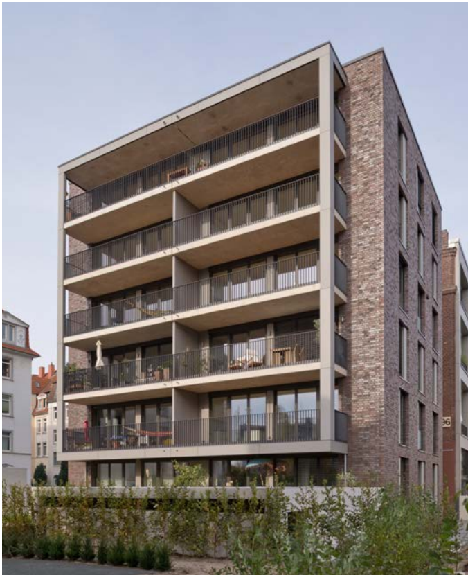
Eine Bauherrengemeinschaft hat in Zusammenarbeit mit dem hannoverschen Architekturbüro agsta neben dem historischen Industriegebäude der Hanomag in Linden ein sechsstöckiges Stadthaus mit elf Lofts errichtet.
