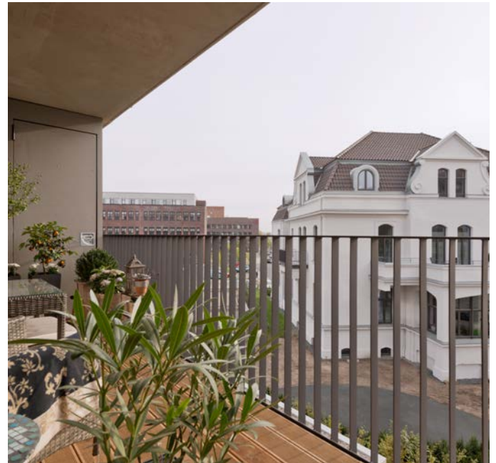
Auf dem ehemaligen Werksgelände der Hanomag in Linden sind, zum Teil in den denkmalgeschützten Industriebauten, neben Büros und Einzelhandel auch Wohnungen entstanden.
