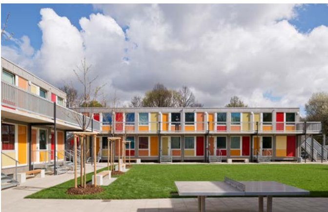
Das Konzept des Flüchtlingswohnheims Steigerthalstraße : preiswertes Wohnen in Holzmodulen. Gezeigt wurde es auf der Architektubiennale in Venedig im Deutschen Pavillon im Rahmen des Projektes „Making Heimat“ vom Deutschen Architekturmuseum Frankfurt. Drei Wohnanlagen mit Holzmodulen hat das hannoversche Büro Mosaik Architekten an verschiedenen Standorten in Hannover geplant.
