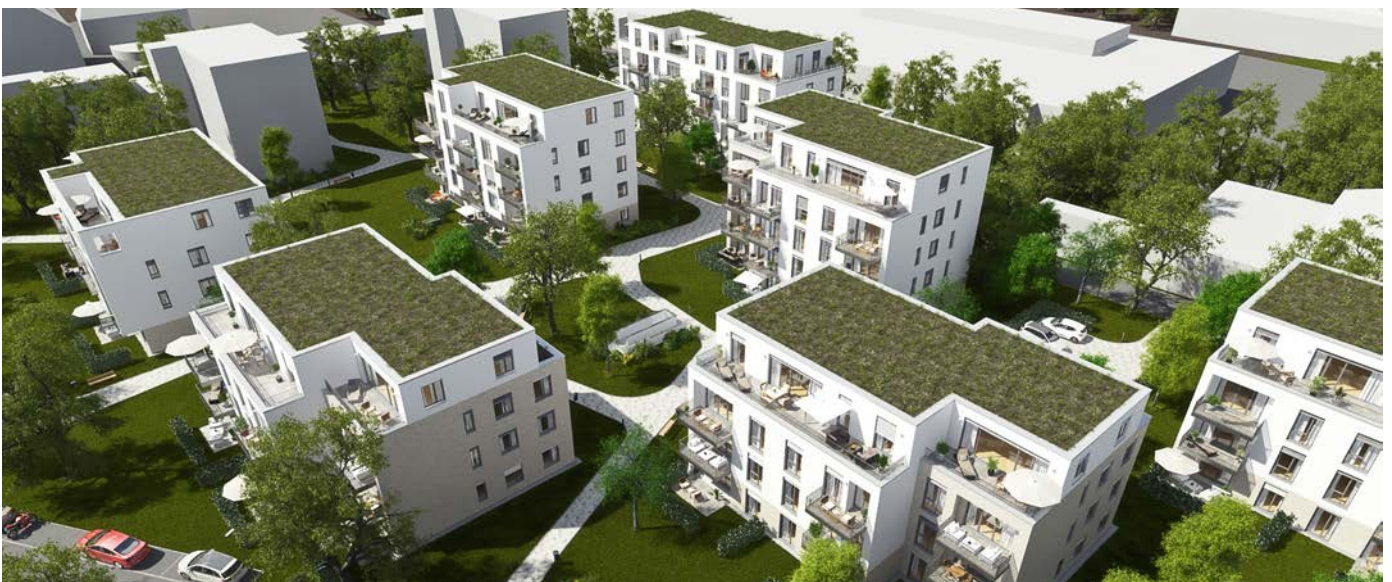
Auf einem rund 14.500 qm großen Grundstück im Norden der Stadtparkallee in Langenhagen baut Helma Wohnungsbau direkt am Stadtpark sieben Mehrfamilienhäuser mit insgesamt 90 Wohnungen und einem erwarteten Umsatz von 26 Mio. Euro.
