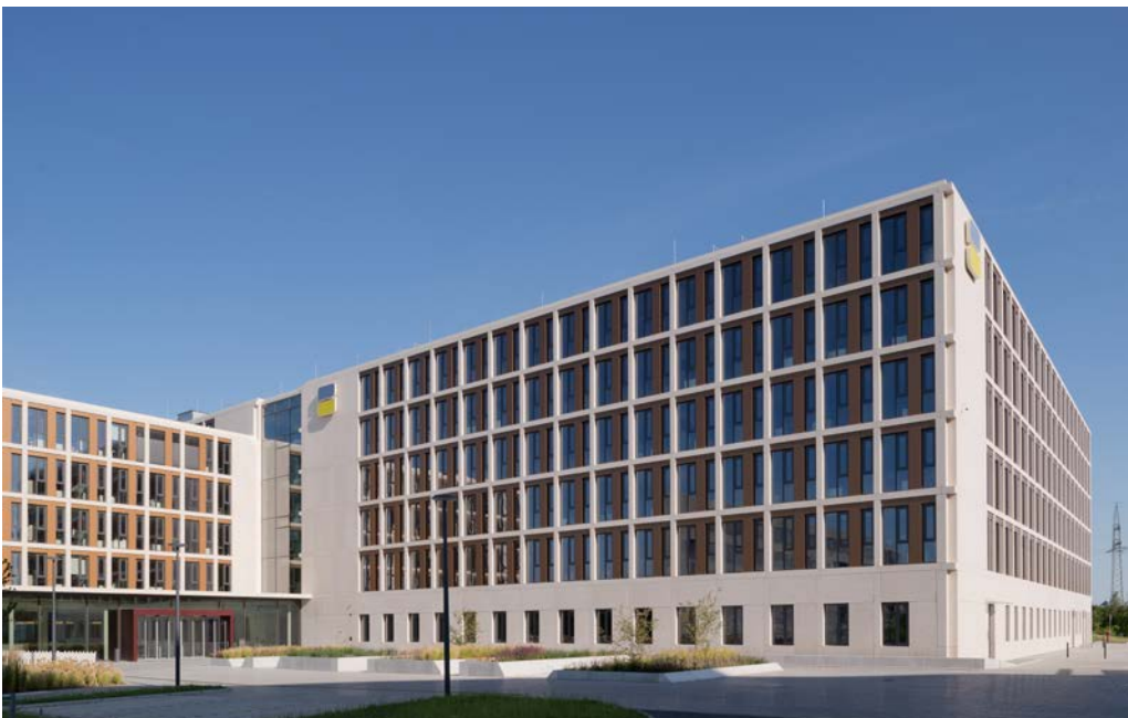
Die Deutsche Rentenversicherung hat in Laatzen rund 67 Mio. Euro in ein neues Verwaltungsgebäude investiert. Mit rund 18.500 qm MF-G ist der Bau in der Region das größte Bürogebäude außerhalb der Landeshauptstadt.
