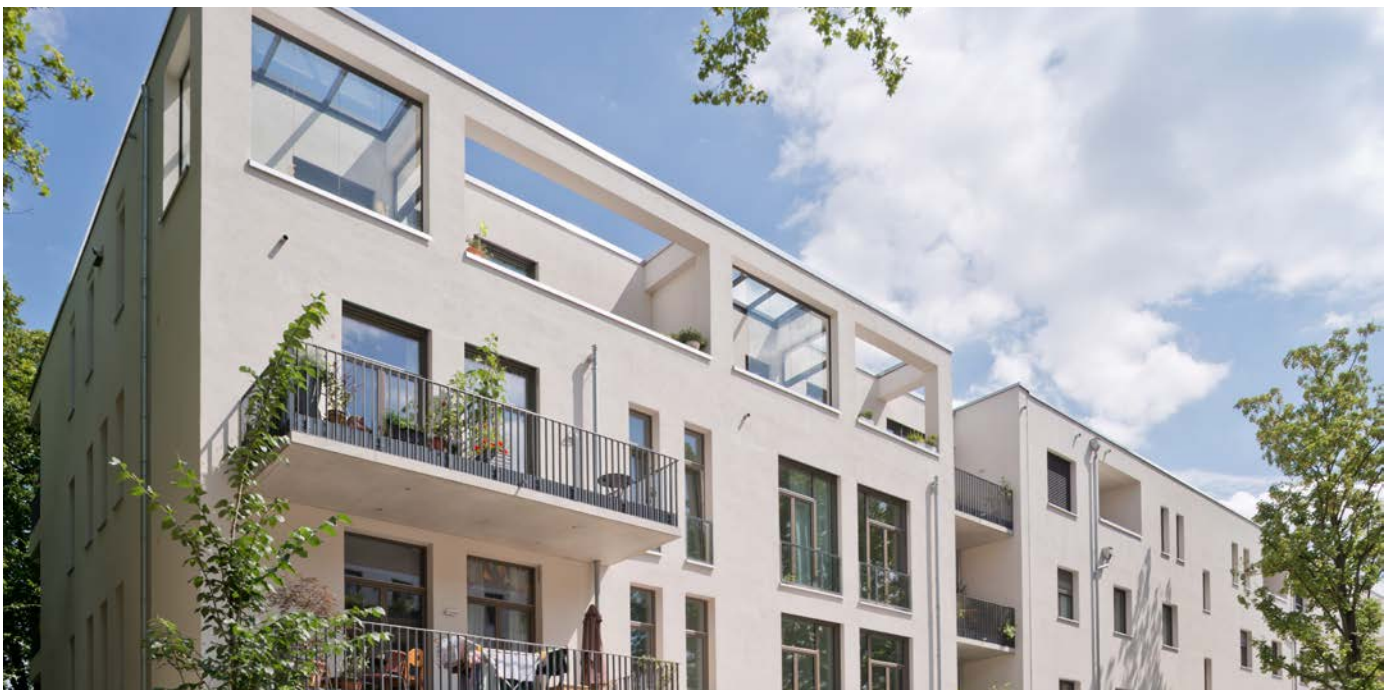
Ihmeuen: Auch auf dem Areal der ehem. Hautklinik in Linden engagieren sich mehrere Bauherrengemeinschaften. Auf dem Gelände am Ihmeufer sind knapp hundert Wohnungen entstanden.
